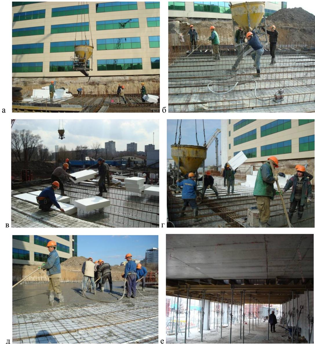
Рис. 11. Устройство облегченного железобетонного перекрытия: а и б – подача и укладка бетона; в – установка вкладышей на свежий бетон; г – переноска вкладышей; д – укладка бетона верхней части перекрытия; е – установка опалубки на второй захватке
