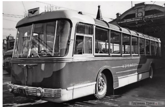
Рис. 12. Електробус, побудований для аеропорту «Внуково» на базі тролейбуса СВАРЗ
