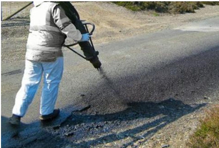
Рисунок 3 - Струменево-ін'єкційна холодна технологія ремонту
