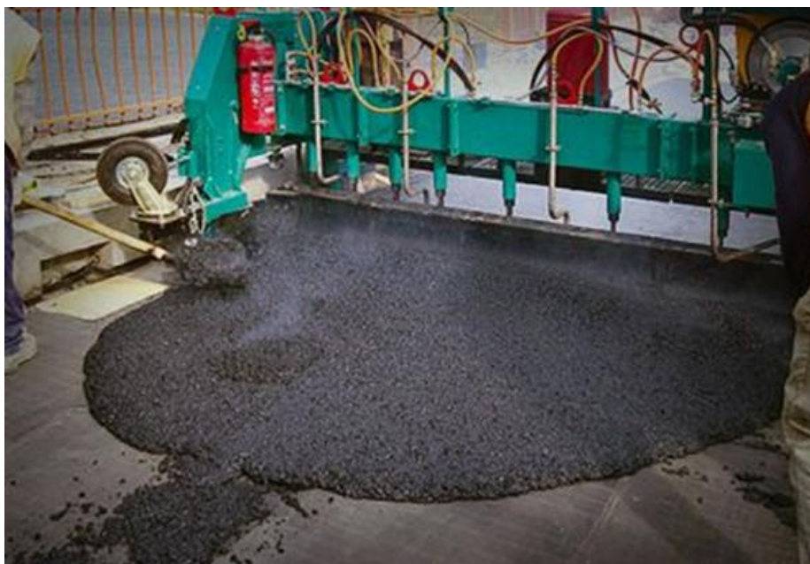
Рисунок 2 – Розподіл асфальтобетонної суміші
