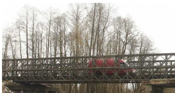
Рисунок 8 - Двоповерховий модульний міст, який передано з Франції та встановлено на Чернігівщині
