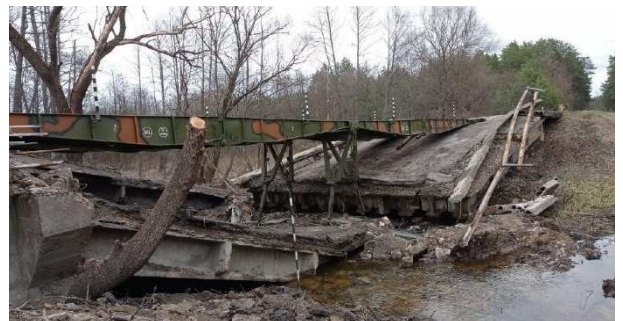
Рисунок 16 – Важкий механізований міст ТММ-3, який встановлено на автомобільній дорозі Р-69 між м. Чернігів та м. Київ.
