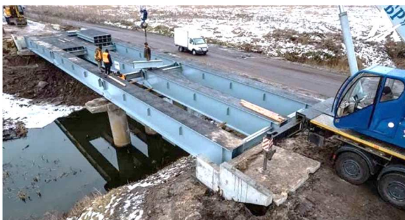
Рисунок 12 - Модульний міст UNIBRIDGE® виробництва компанії Matiere (Франція) на стадії монтажу
