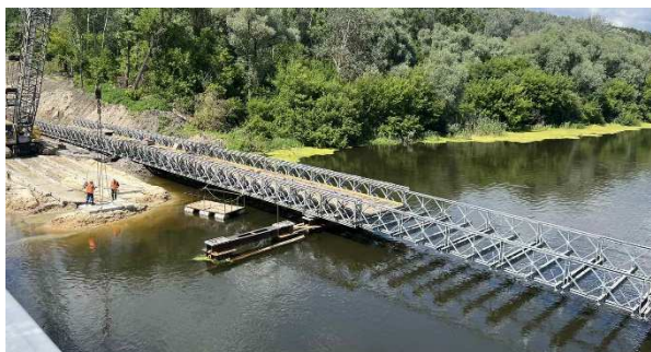
Рисунок 7 - Збірно-розбірний міст Bailey Bridge, який влаштовано у
