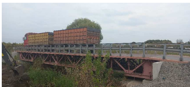
Рисунок 4 - Збірно-розбірний міст САРМ, який після відновлення встановлено у Харківській області
