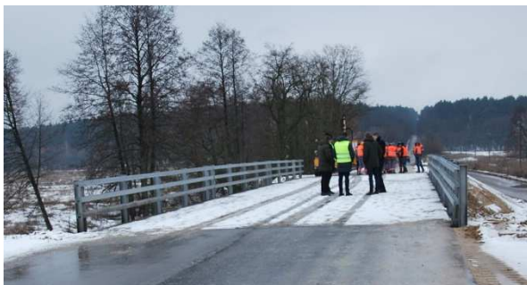
Рисунок 13 - Модульний міст UNIBRIDGE® виробництва компанії Matiere, який збудовано в Чернігівській області
