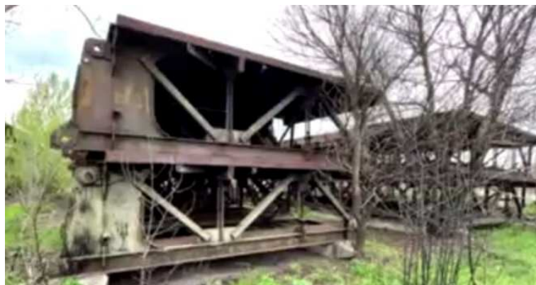
Рисунок 3 - Стан комплекту САРМ, що зберігався на складі
