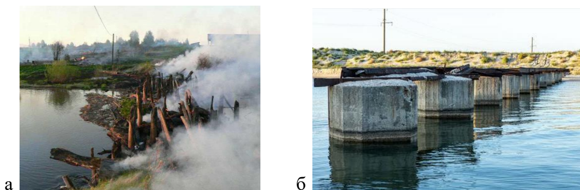
Рисунок 5 – Залишки мостів після пожежі (а, б) [2]
