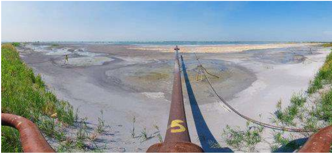
Рис. 5.8. Розподіл фракцій золошлакових відходів по території золовідвалу: у центрі зона великих частинок, по периметру – зольна зона
