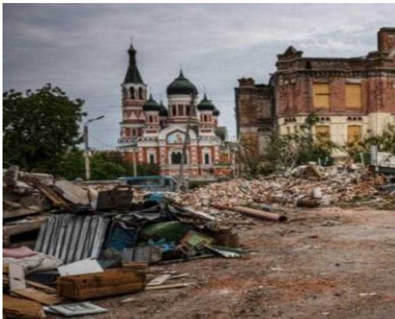
Рис.1 – Руйнування історичної будівлі внаслідок війни в центрі м. Харків
