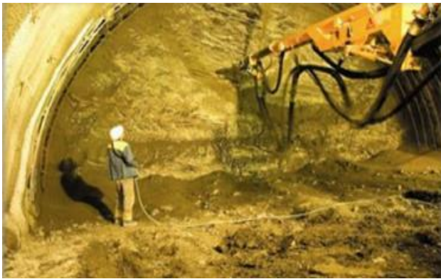
Рисунок 2 – Нанесення набризк-бетону в тунельних спорудах
