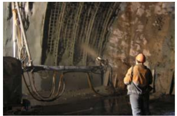
Рисунок 2 – Нанесення набризк-бетону в тунельних спорудах
