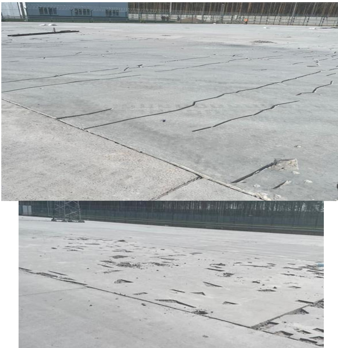
Рисунок 3 – ЦСВЯП - дефекти поверхні майданчику для захоронення відпрацьованого ядерного палива на 2021 рік ( facebook.com/olga.kosharna )
