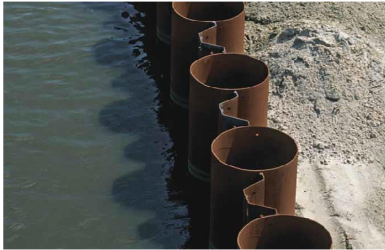
Рисунок 2 – Варіант комбінованої шпунтової стінки
