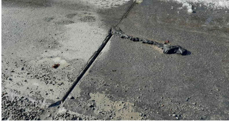
Рисунок 2 – Розгерметизовані деформаційні шви
