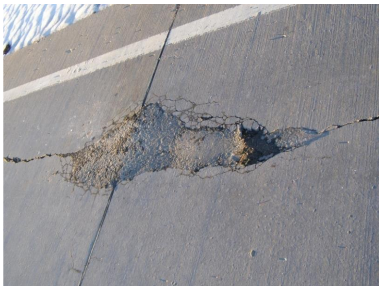
Рисунок 4 – Подальше руйнування відремонтованих вибоїн
