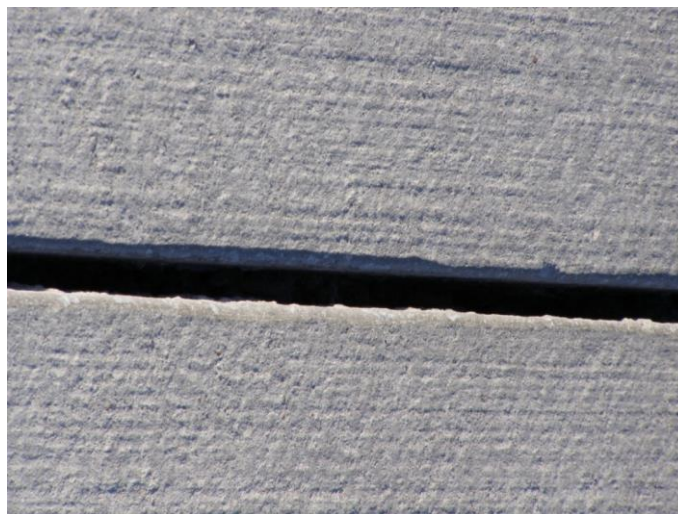
Рисунок 6 – Приклад не загерметизованих деформаційних швів
