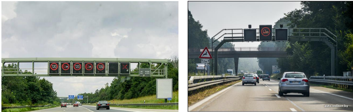
Рис. 5. Інформаційна конструкція балочної та рамкової системи
