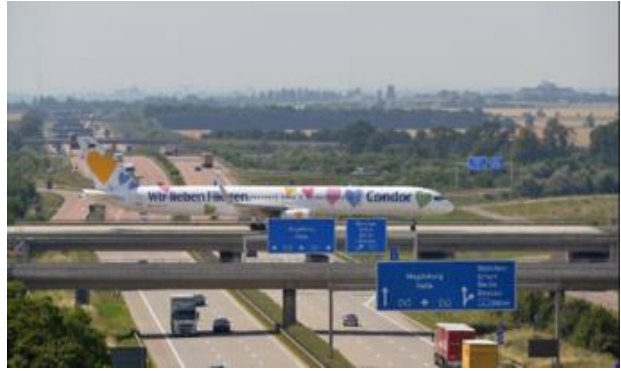
Рис. 1. Динамічне навантаження шляхопроводів літаками
