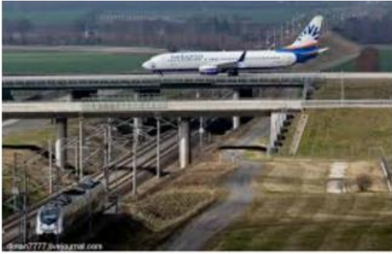
Рис. 1. Динамічне навантаження шляхопроводів літаками
