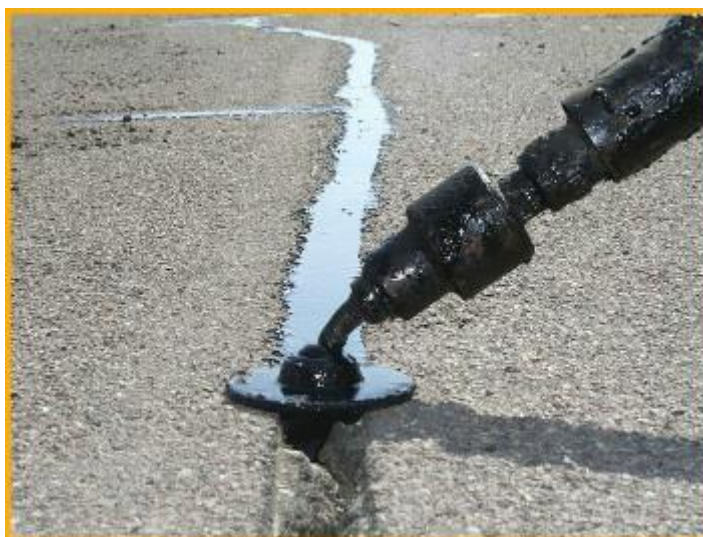
Рисунок 2 – Ремонт тріщин мастикою
