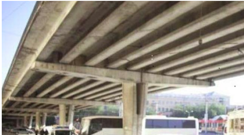
Рисунок 4 – Рамні опори Т-образні
