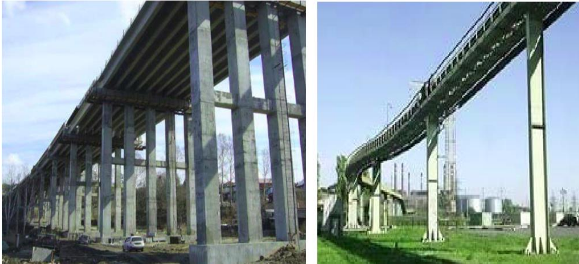
Рисунок 2 – Стійкові опори високої естакади
