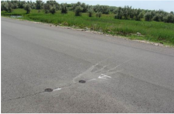
Рисунок 3 – Загальний вигляд ділянки
