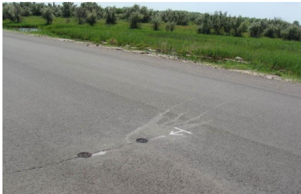
Рисунок 3 – Загальний вигляд ділянки
