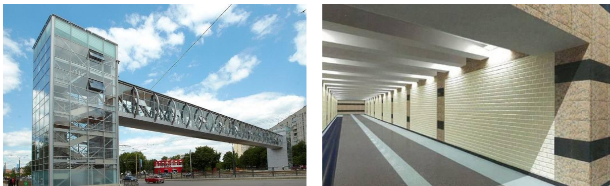
Рисунок 1 – Загальний вид пішохідного мосту і тунелю
