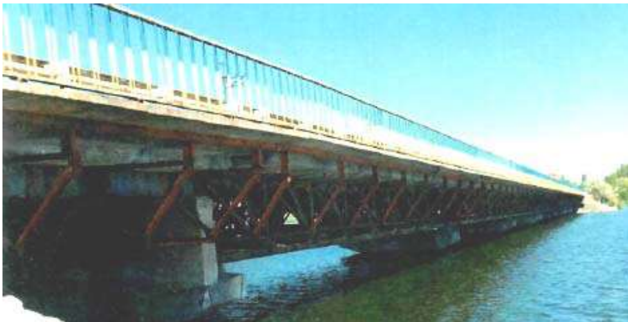
Рисунок 5 – Загальний вигляд мосту
