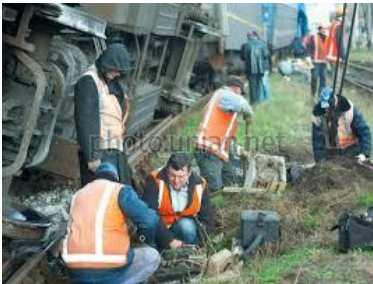
Рисунок 2 – Роботи по ліквідації наслідків аварії на залізничному транспорті
