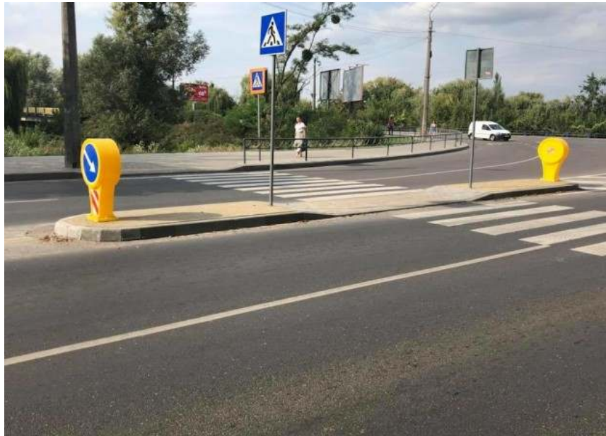
Рисунок 2 - Облаштування островців безпеки на нерегульованому пішохідному переході у місті Луцьку (реалізований проект) [4]
