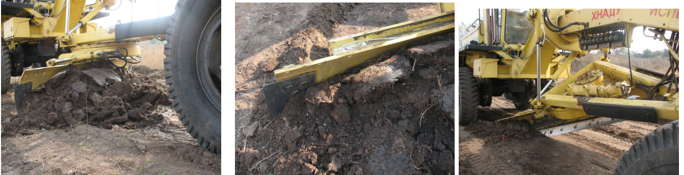
Рисунок 7 – Різання та зарізання ґрунту заданою товщиною
