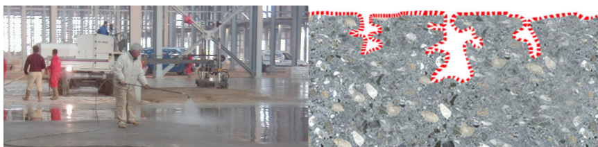
Рис. 4. Ремонт поверхні цементобетону зміцнюючим просоченням Sikafloor® CureHard LI
