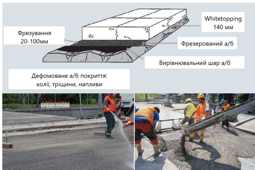
Рис. 1. Ремонт дорожнього одягу за технологією «Whitetopping»
