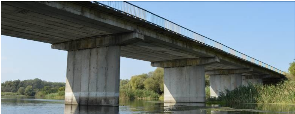
Рисунок 1 – Загальний вид моста з верхової сторони
