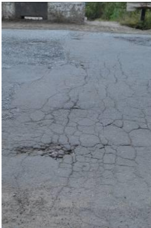
Рисунок 5 – Сітка тріщин в асфальтобетоні на підходах до моста
