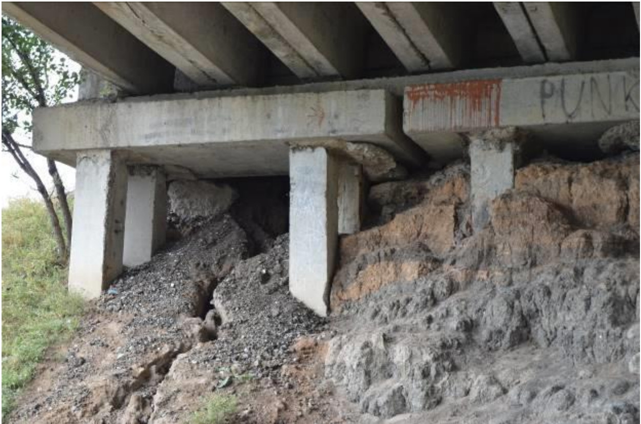
Рисунок 4 – Руйнування лобових укосів берегової опори ОП 7
