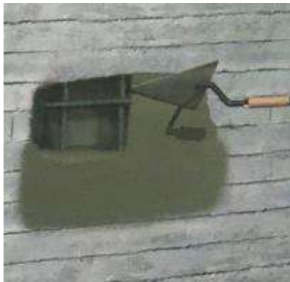
Рисунок 6 – Заповнення втрат в бетоні ремонтними розчинами SikaMonoTop 612 / 412 N / 412 NFG методом “мокре по мокрому” по свіжому адгезійному шару
