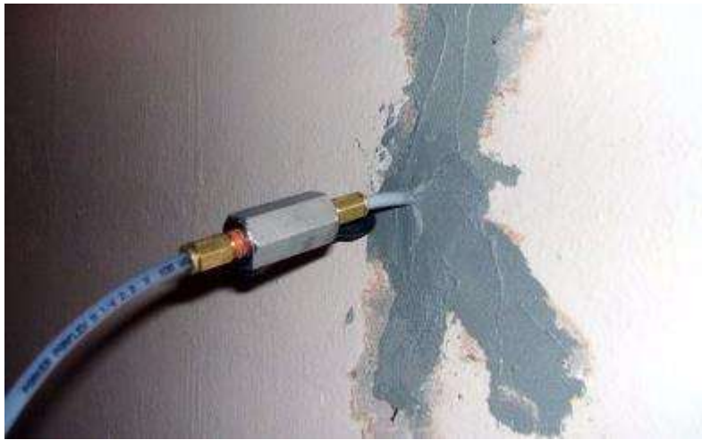
Рисунок 1.8 – Відновлення залізобетону методом ін'єктування
