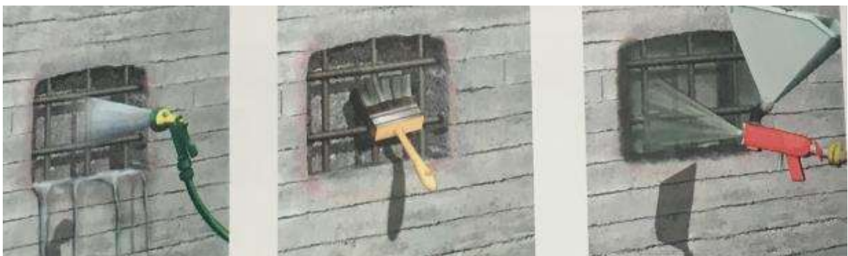
Рисунок 5 – Промивання і зволоження поверхні, що ремонтується
