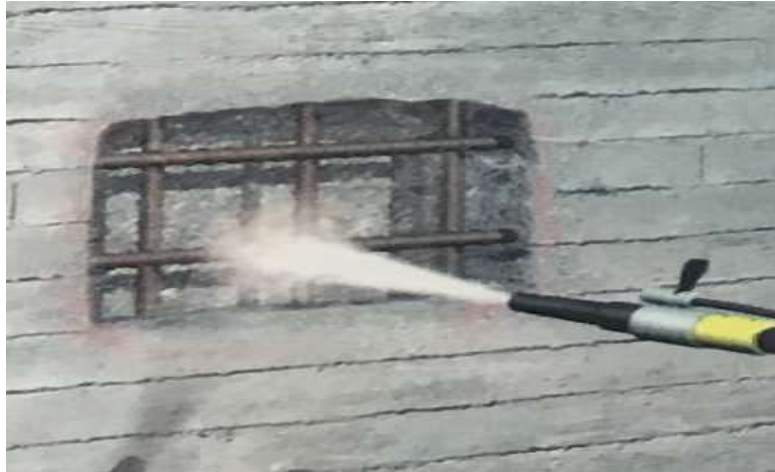
Рисунок 3 – Очистка арматури від корозії
