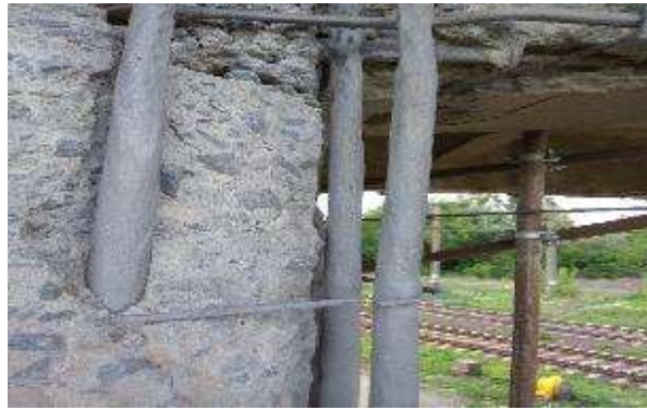
Рисунок 4 – Антикорозійний захист арматури Sika MonoTop- 910 N
