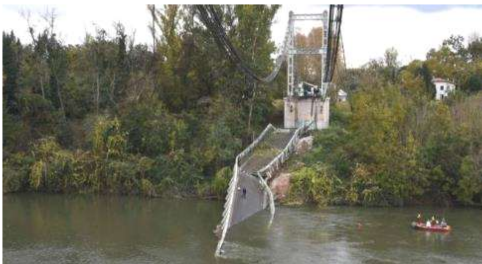
Рисунок 2 – Руйнація мосту внаслідок перевантаження ваговиком (Франція, 2019)
