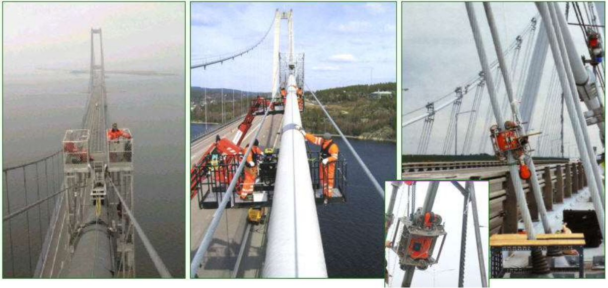
Рисунок 4 – Моніторинг кабелів і підвісок висячих мостів
