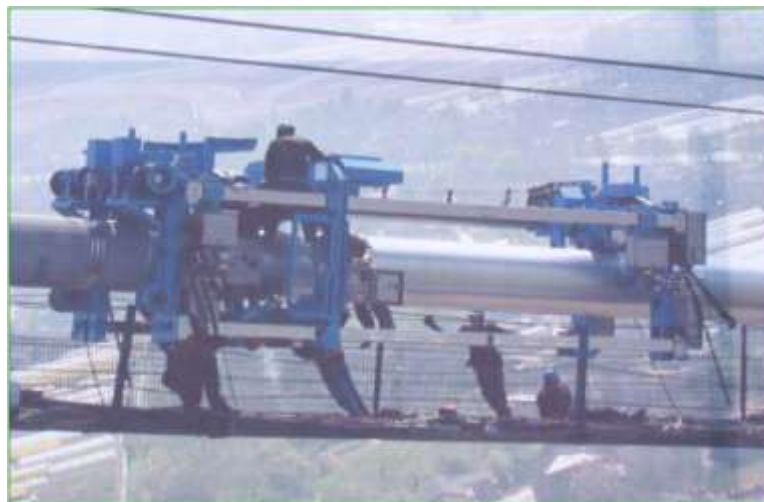
Рисунок 6 – Улаштування обмотки дротом несучих канатів
