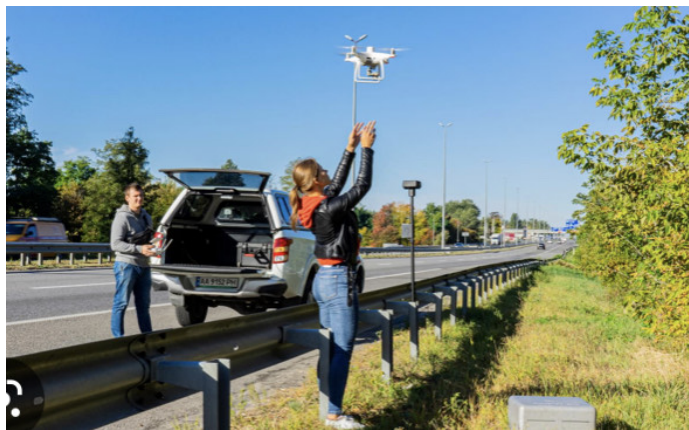
Рисунок 1. Запуск дрону для вивчення дорожнього покриття.
