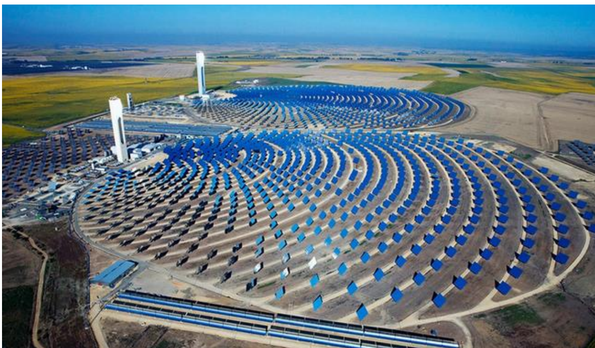
Рисунок 1.6 – Баштові сонячні електростанції
