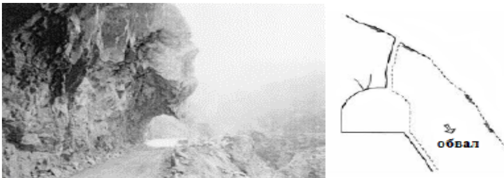
Рисунок 2 – Руйнування тунельної оправи внаслідок обвалу укосу
