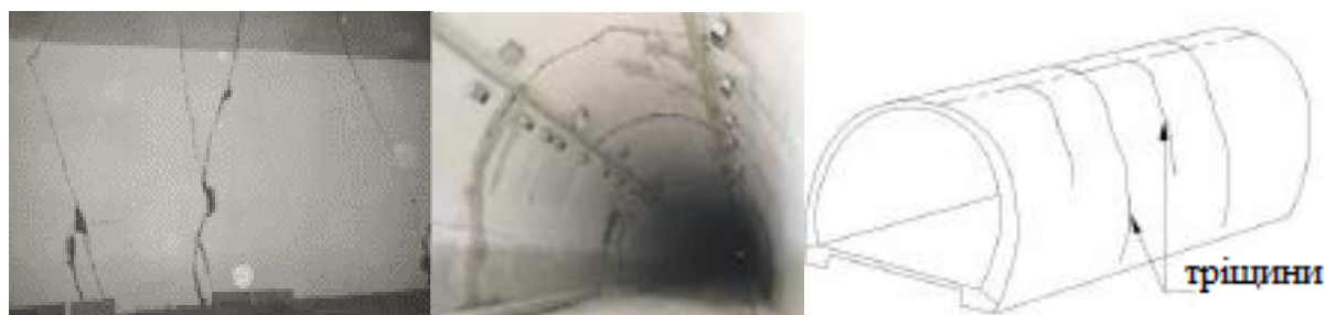
Рисунок 4 – Поперечні тріщини
