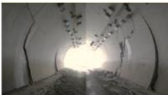
Рисунок 7 – Деформація стін
