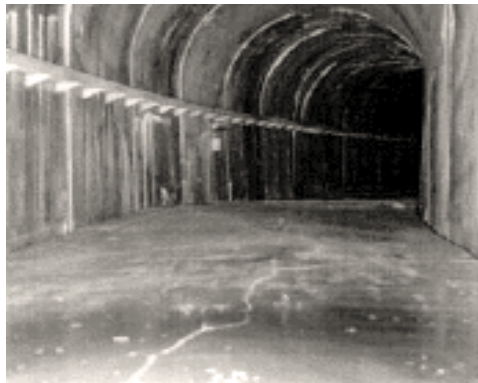
Рисунок 6 – Тріщини в лотковій частині тунелю
