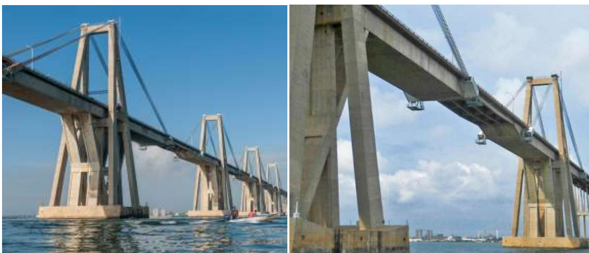
Рисунок 8 – Загальний вигляд вантових прогонових будов мосту через озеро Маракайбо (Венесуела)
