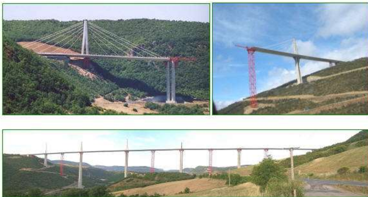
Рисунок 2 – Момент будівництва мосту Мійо
