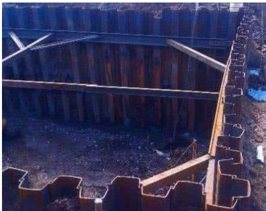
Рисунок 3 - Шпунти типу «Ларсен»
