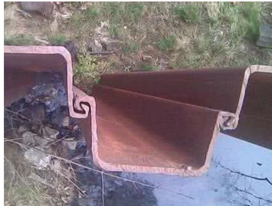
Рисунок 3 - Шпунти типу «Ларсен»
