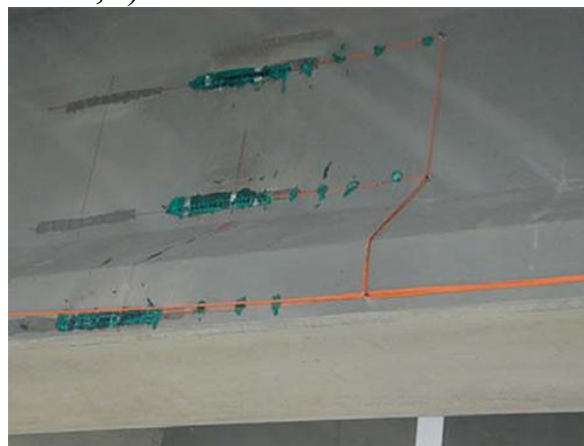
Рисунок 2 – Оптоволоконні датчики: а – вбудовані; б – на бетонних балках
