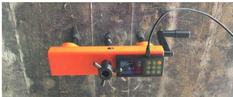
Рисунок 2 – Встановлений прибор для випробування бетону плити прогонової будови мосту через р. Сіверський Донець біля с. Старий Салтів методом відриву зі сколюванням
