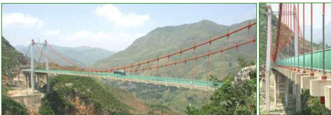
Рисунок 7 – Висячий міст із залізобетонною балкою жорсткості (Китай)
