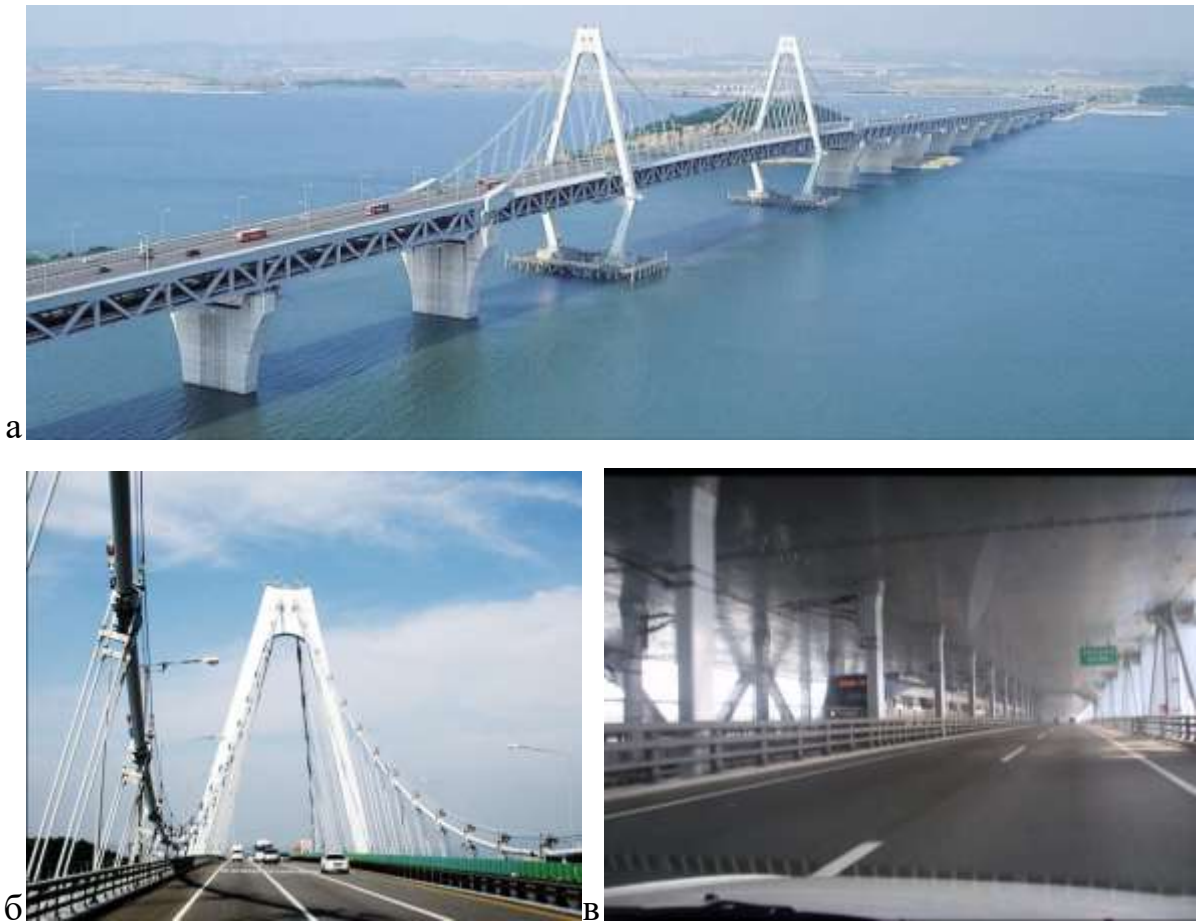
Рисунок 4 – Безрозпірний висячий міст Сорок (Південна Корея): а - вигляд; б – верхній рівень проїзду; в – нижній рівень проїзду
