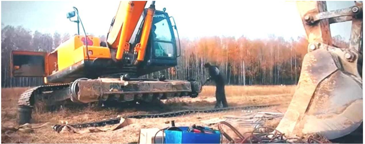
Рис. 14.7 – Ремонт ходової частини гусеничного екскаватора в польових умовах
