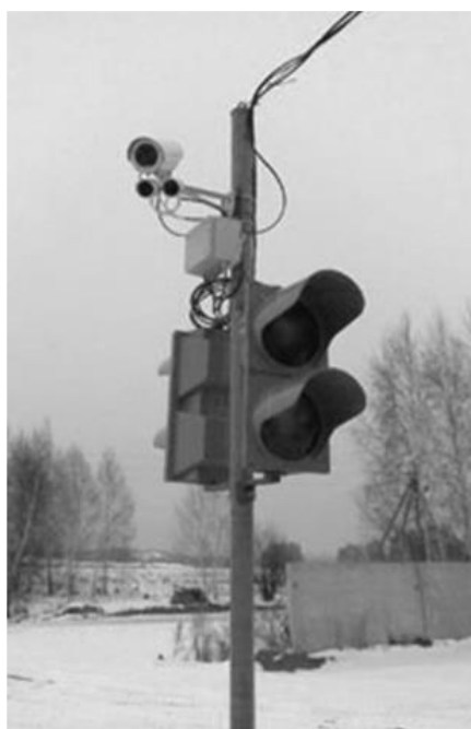
Рисунок 2 - Відеокамера системи оптичної ідентифікації
