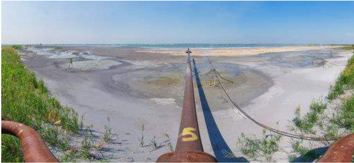
Рис. 6.8. Розподіл фракцій золошлакових відходів по території золовідвалу: у центрі зона великих частинок, по периметру – зольна зона
