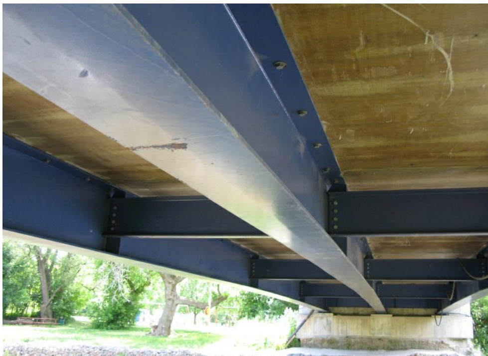
Рисунок 1 – Вид з низу прогонової будови з деревини, GFRP оболонки та сталевих балок
