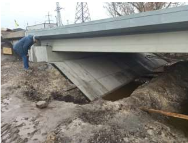
Рис. 3.31 – Укріплення конусу насипу стояна №4
