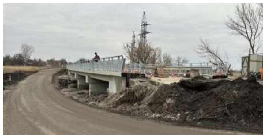
Рис. 3.36 – Загальний вигляд мосту
