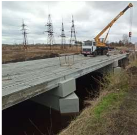
Рис. 3.11 – Льодорізи проміжних опор
