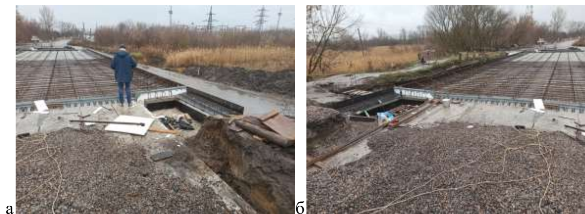
Рис. 3.25 – Перехідна плита на стоян №4
