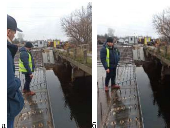
Рис. 3.24 – Зовнішня металева опалубка плити прогонової будови
