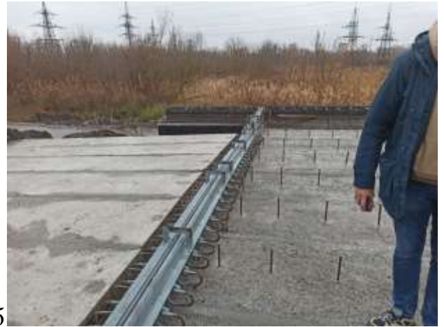
Рис. 3.27 – Деформаційний шов та перехідна плита над стояном №1
