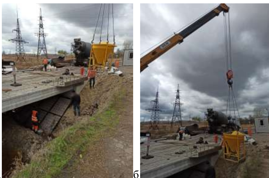
а б Рис. 3.18 – Підготовка до бетонування конусу насипу стояна №4
