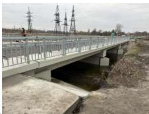
Рис. 3.37 – Монтаж перильної огорожі на мосту (а); улаштування гідроізоляції на проїзній частині та тротуарах мосту (б)
