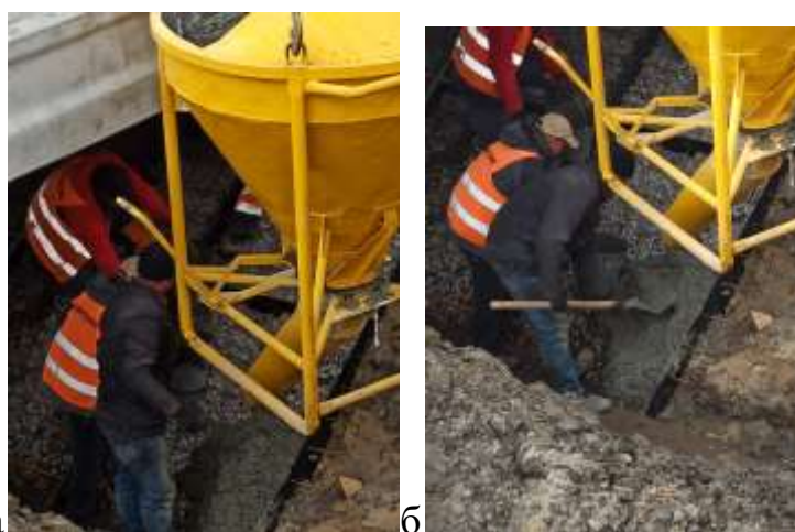
а б Рис. 3.19 – Бетонування укріплення конусу насипу стояна №4
