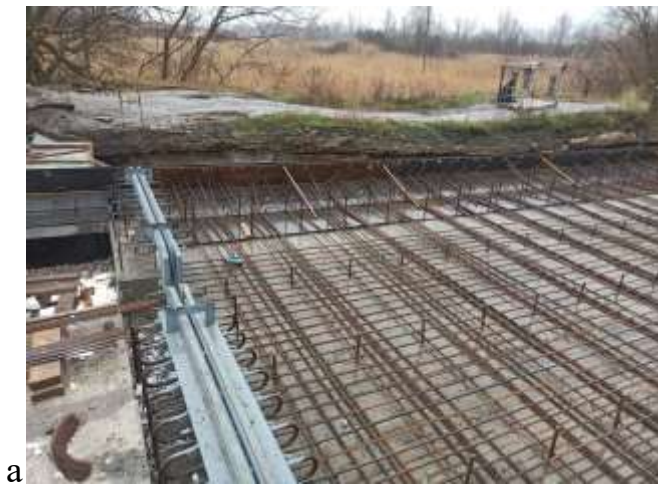
Рис. 3.26 – Деформаційний шов над стояном №4
