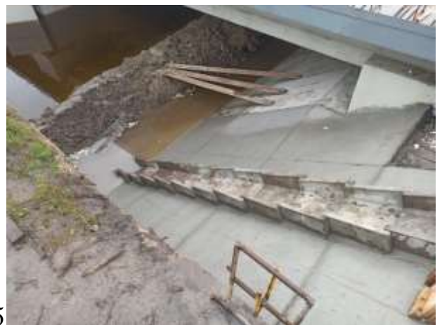
Рис. 3.28 – Улаштування водовідводу на стояні №4
