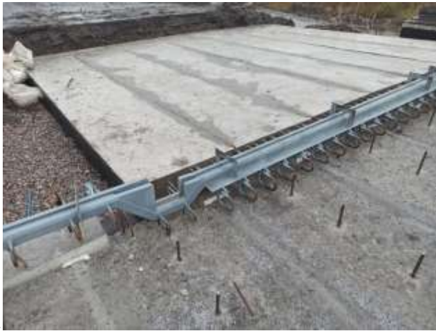
Рис. 3.27 – Деформаційний шов та перехідна плита над стояном №1
