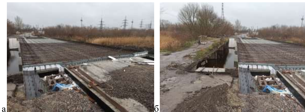
Рис. 3.23 – Армування монолітної плити прогонової будови
