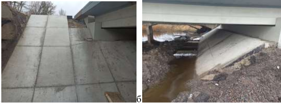
Рис. 3.32 – Укріплення конусу насипу стояна №1
