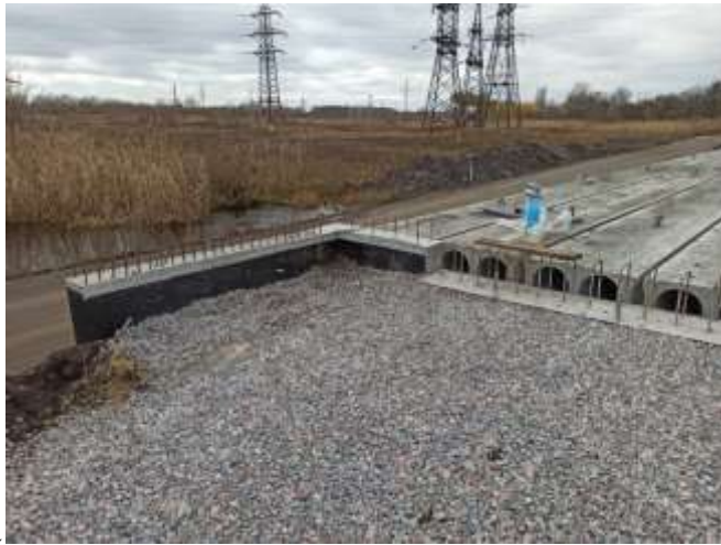
Рис. 3.9 – Щебенева подушка під перехідні плити (з боку с. Вербівка)
