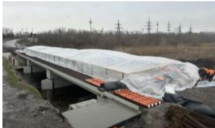
Рис. 3.35 – Бетонування монолітної плити проїзної частини
