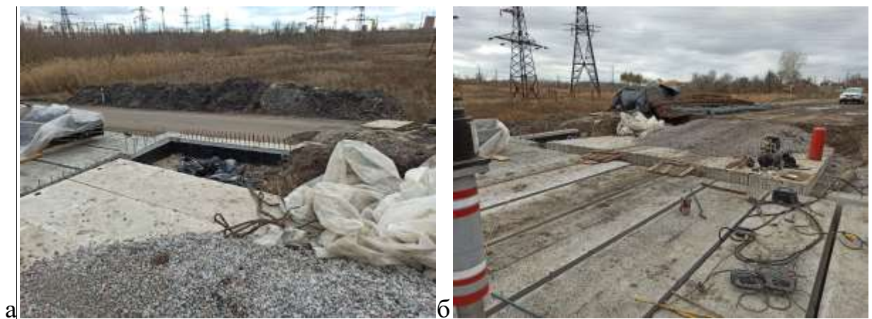
Рис. 3.22 – Перехідна плита на стоян №4
