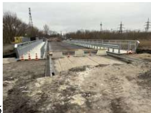
Рис. 3.37 – Монтаж перильної огорожі на мосту (а); улаштування гідроізоляції на проїзній частині та тротуарах мосту (б)
