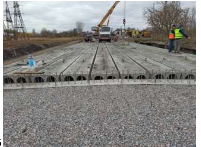
Рис. 3.9 – Щебенева подушка під перехідні плити (з боку с. Вербівка)
