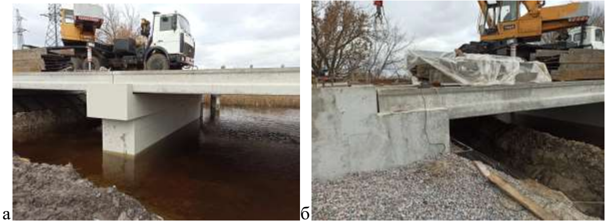
Рис. 3.14 – Проміжна опора №3 (а), стоян №4 (б)
