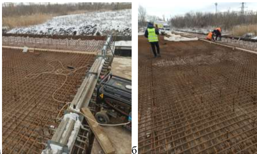
Рис. 3.34 – Укладання арматури для монолітної плити прогонової будови роботи
