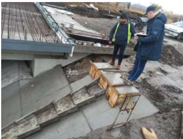
Рис. 3.28 – Улаштування водовідводу на стояні №4
