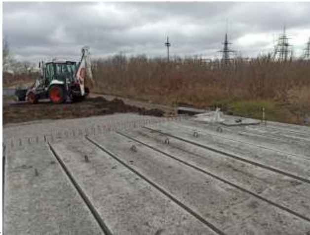
Рис. 3.12 – Збірні залізобетонні плити прогонових будов
