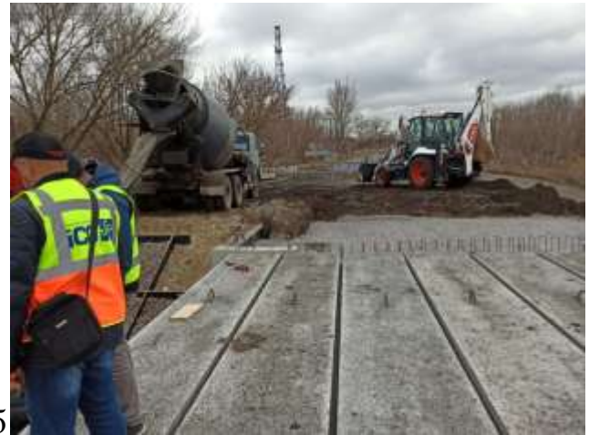
Рис. 3.12 – Збірні залізобетонні плити прогонових будов
