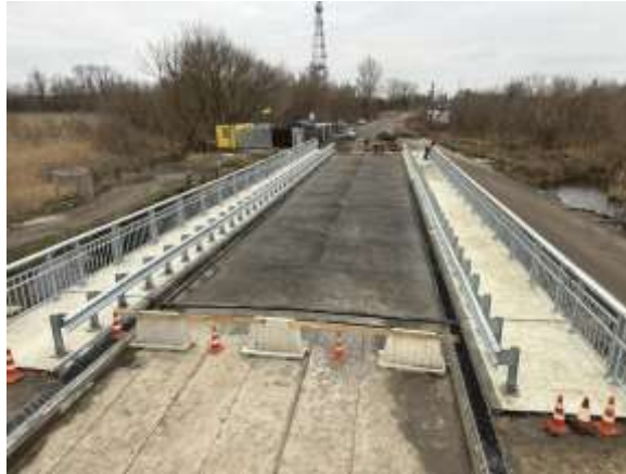
Рис. 3.38 – Проїзна частина та тротуари мосту
