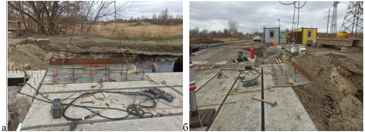
Рис. 3.20 – Зовнішня металева опалубка монолітної плити проїзної частини
