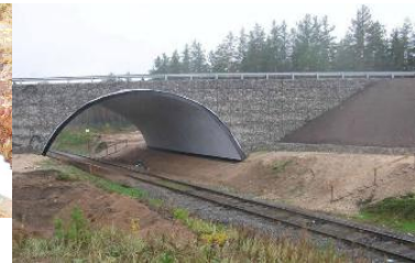
Шляхопровід над з/д
