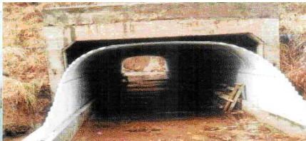
Приклад ремонту з/б труби збірною металевію гофрованою аркою засобом «гільзування»
