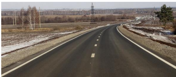
Рис. 14. Вид дороги с кривыми переменной скорости VGV_Kurve
