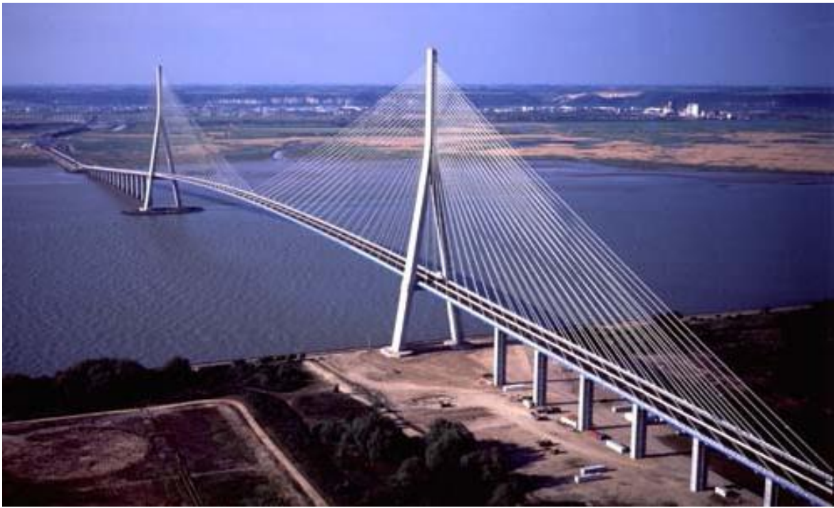
Рис. 13. Міст Нормандія був побудований в 1995 році у Франції. Він перетинає річку Сену між Нормандією і Гавром. Центральний проліт становить 935 м. Вся довжина – більше 2-х км
