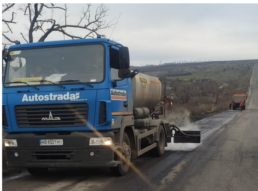
Рисунок 3 – Підґрунтовка карти бітумною емульсією
