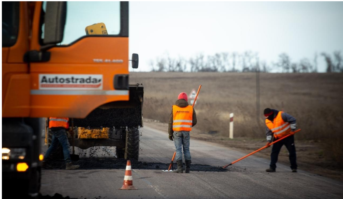
Рисунок 4 – Укладання та розрівнювання суміші вручну
