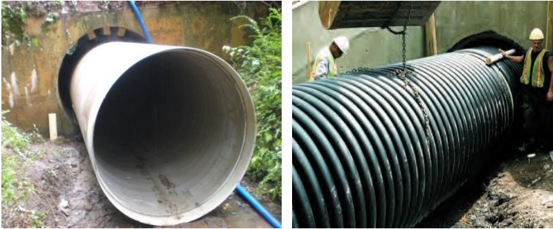
Рис. 1. Ремонт методом «гільзування» залізобетонної труби
