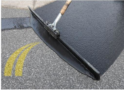
Рис.2. Влаштування ультратонкого покриття вручну
