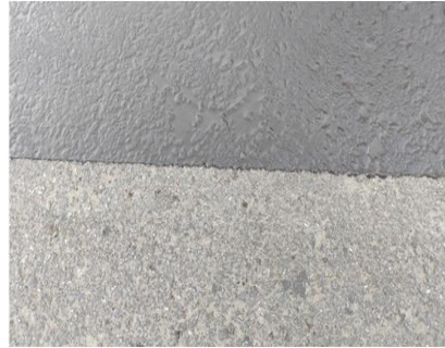
Рис.3. Приклад старого асфальтобетону (внизу) та відремонтованого (вгорі)
