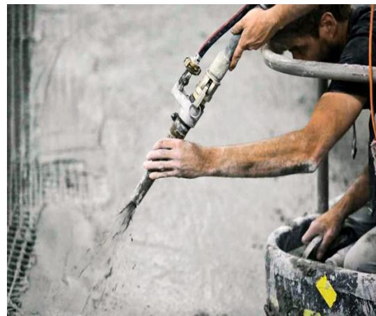
Рис. 1.9. Проєкт NEST HiLo shell roof : а – монтаж сітки з тросів; б – закріплення полімерної плівки; в – укладання арматури; г – нанесення бетонної суміші першого шару; д – нанесення бетонної суміші другого шару; е – готова конструкція [24]
