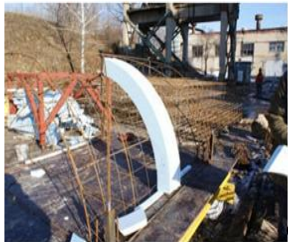
Рис. 1.14. Елементи самонесучого остова залізобетонних оболонок: а–г – елементи остова для фрагмента циліндра, сфери, нодіда та гіпару; д – верстат для розкрою листів пінополістиролу; е – процес установки вкладишів в остов
