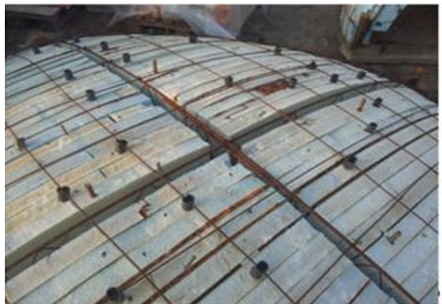
Рис. 1.15. Самонесучі остови залізобетонних оболонок: а–г для циліндра, сфери, нодоїда та гіпару; д – вид фрагмента плоского каркасу; е – розташування вкладишів у самонесучому остові
