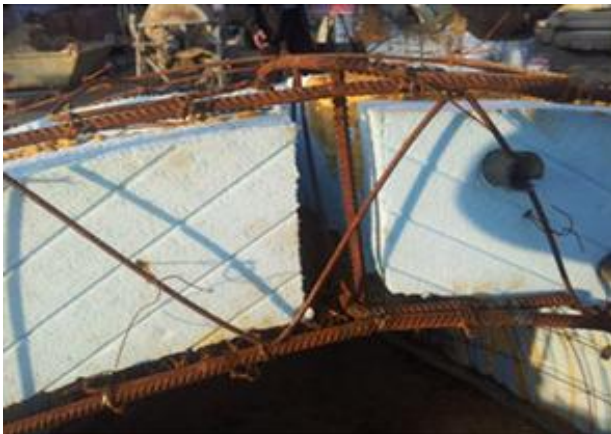
Рис. 1.15. Самонесучі остови залізобетонних оболонок: а–г для циліндра, сфери, нодоїда та гіпару; д – вид фрагмента плоского каркасу; е – розташування вкладишів у самонесучому остові
