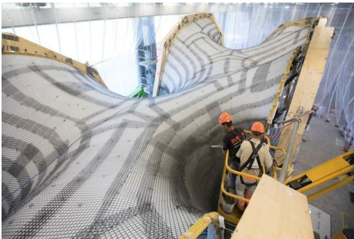
Рис. 1.9. Проєкт NEST HiLo shell roof : а – монтаж сітки з тросів; б – закріплення полімерної плівки; в – укладання арматури; г – нанесення бетонної суміші першого шару; д – нанесення бетонної суміші другого шару; е – готова конструкція [24]
