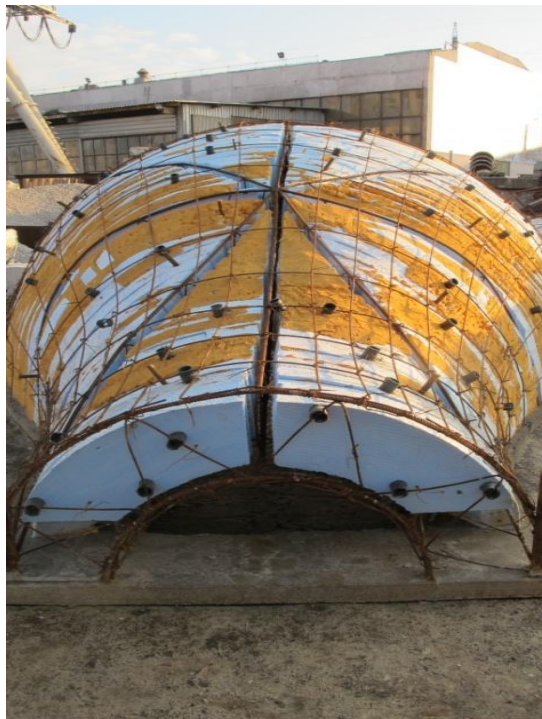
Рис. 1.36. Незнімна опалубка для виготовлення конструкції нодоїдальної оболонки: а – площини розкрою упоперек нодоїда; б – визначення кількості елементів; в – форма вкладишів; 1–11 – номери елементів
