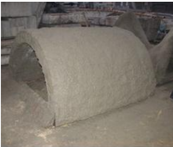
Рис. 1.16. Бетонування монолітної залізобетонної оболонки: а – торкрет-установка; б – заповнення ребер; в – торкретування зовнішньої обшивки; г – нанесений перший шар торкрет-бетону на зовнішню сторону остова; д – зовнішній вигляд торкрет-бетону перед нанесенням фінішного шару; е – торкретування внутрішньої обшивки
