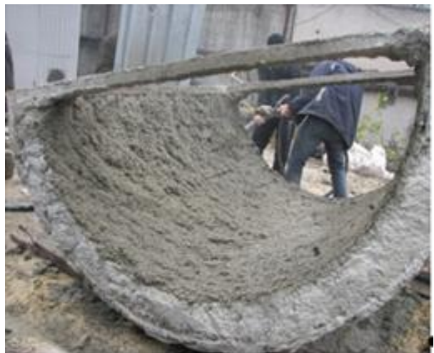
Рис. 1.16. Бетонування монолітної залізобетонної оболонки: а – торкрет-установка; б – заповнення ребер; в – торкретування зовнішньої обшивки; г – нанесений перший шар торкрет-бетону на зовнішню сторону остова; д – зовнішній вигляд торкрет-бетону перед нанесенням фінішного шару; е – торкретування внутрішньої обшивки
