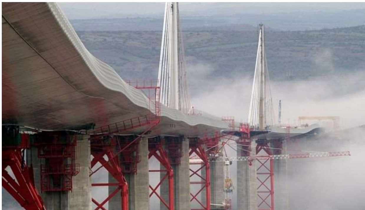
Рисунок 2 - Процес будівництва віадуку [7]
