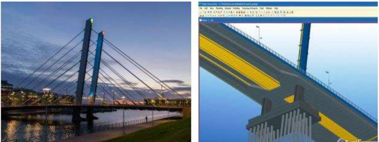
Рисунок 1 – Міст Crusell (Фінляндія) та інформаційна модель мосту [6]
