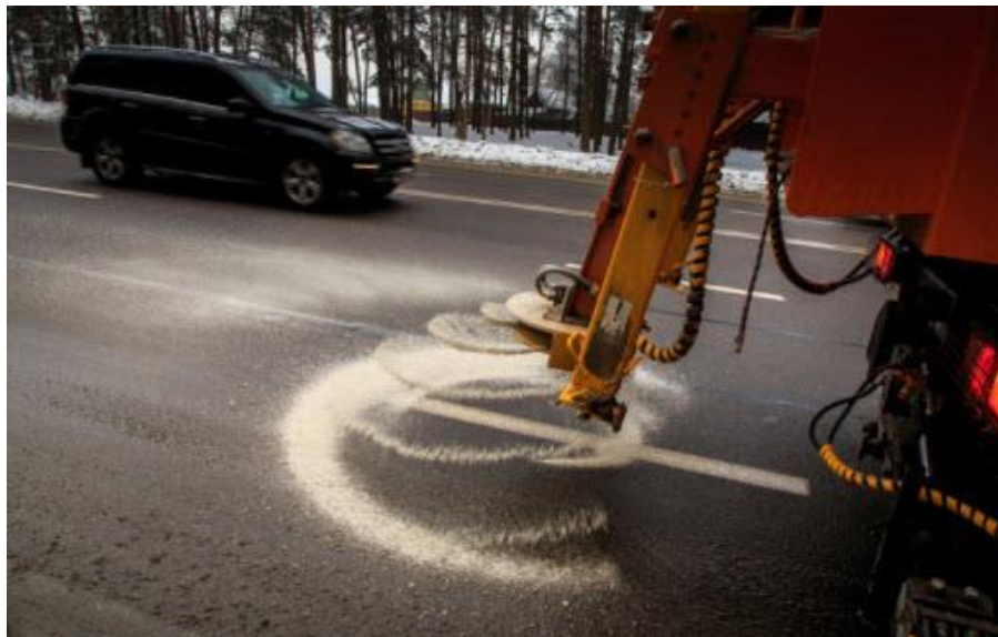
Рисунок 1 – Обробка покриття протижеледними матеріалами
