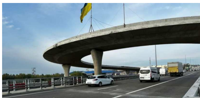
Рисунок 3 – Шляхопровід на а/дорозі міжнародного значення Київ-Чоп.
