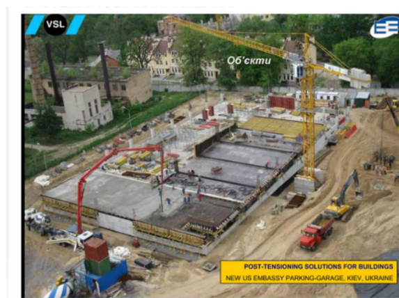
Рисунок 1 – Будівля гаража Посольства США в Києві
